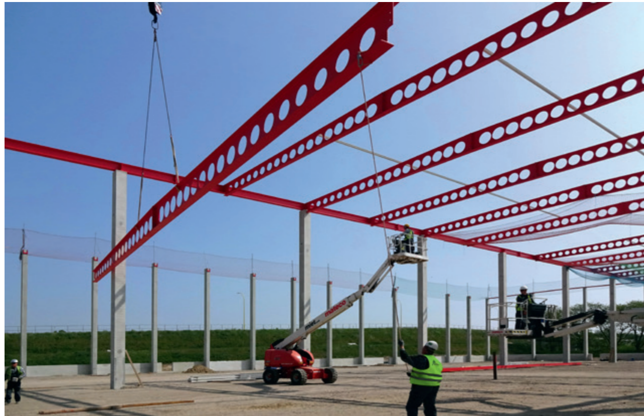
In principle, the use of S355 rolled sections is more cost-effective in hall construction than the steel grade S235. Prinzipiell erweist sich im Hallenbau der Einsatz von S355 Walzprofilen wirtschaftlicher als die Stahlsorte S235.
