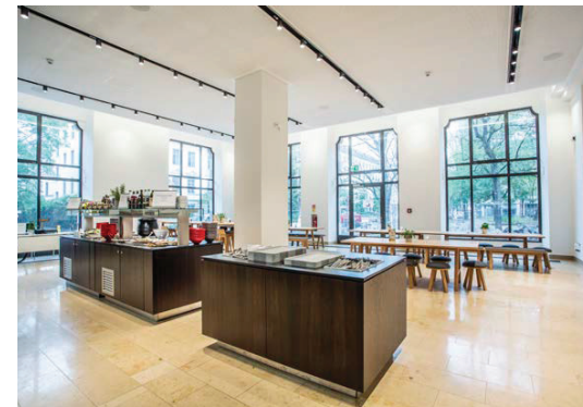
Das Stammhaus der IHK München ist denkmalgeschützt und hat nahe dem Maximilianplatz einen prestigeträchtigen Standort. Niebuhr Stahlglastechnik hat die Fassade mit einem Stahlprofilssystem von Schüco Jansen saniert. Seite 6
