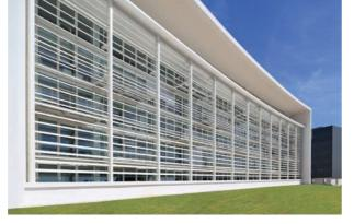
Das Sonnenschutzsystem Wicsolaire wird in horizontaler und vertikaler Bauweise angeboten.
