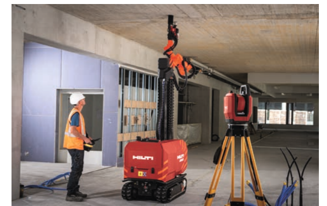
Der Jaibot führt z.B. Bohraufträge an der Decke selbständig aus.
