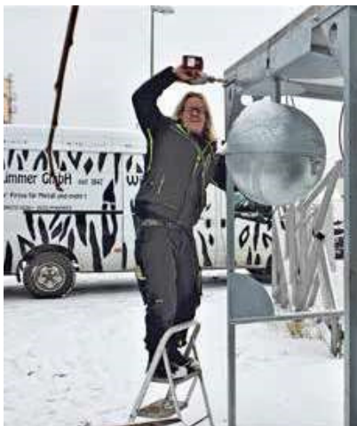
Titelbild: Metallbauer von seele installieren in NYC einen Eingang zur Subway. Foto: seele
