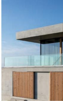
Beim eleganten Ganzglasgeländer GM Railing Uni wurde die Montage vereinheitlicht.
