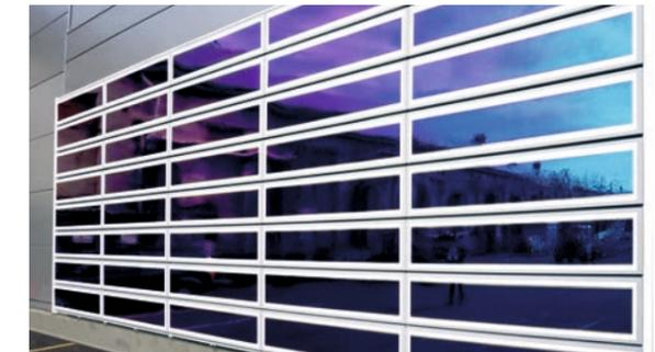
Der VHF-Spezialist zeigt ein fassadenintegriertes Photovoltaik-System auf Basis organischer PV-Elemente.
