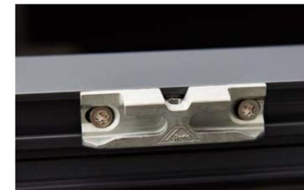
Vorklembares Roto Sicherheitsschließstück für RC2-taugliche Dreh- und Drehkipp-Fenster.
