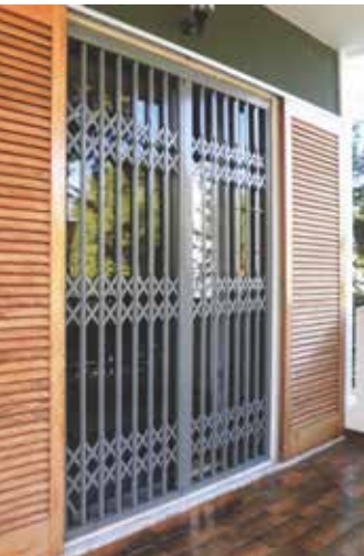
Die Alu-Scherengitter sind Widerstandsklasse RC 2 zugeordnet.
