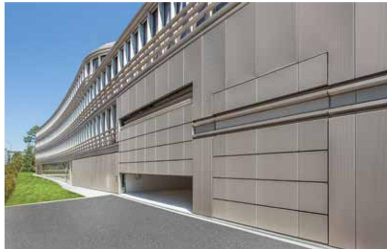
Sektionaltore mit guten Isolierdämmwerten und Lüftungsfunktion sind gut für das Raumklima.
