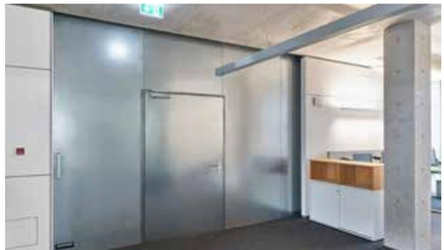
In das Feuerschutz-Schiebetor 62 FST lässt sich eine Türe integrieren.
