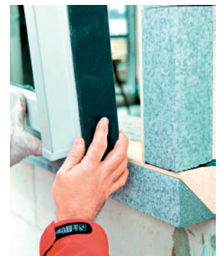
Vorwandmontagesystem erleichtert Fenstereinbau
