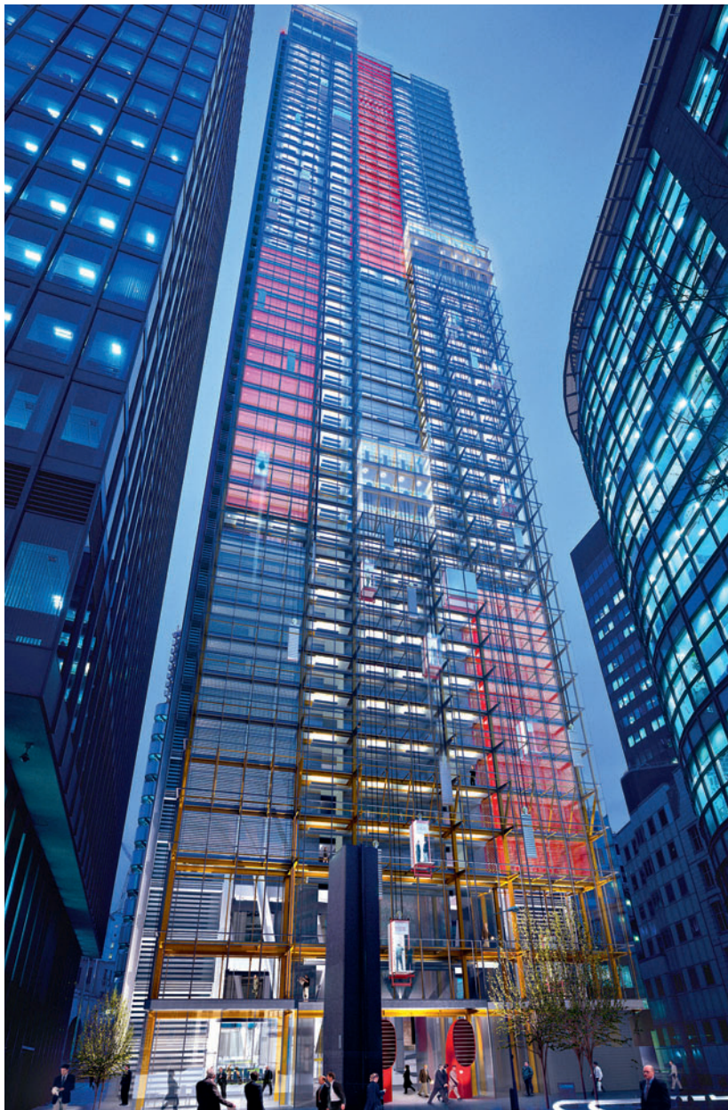
Spezielle Alu-Bandseiten für das Leadenhall Building
