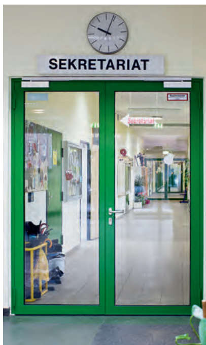
Vollständig in das Mauerwerk integrierte Türe
