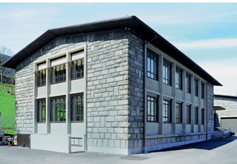
Der Schweizer Betrieb Stauffer Metallbau hat die Fenster des Pumpwerks Schönau renoviert. Projektleiter Urs Scheidegger hat uns erklärt, was bei der Verarbeitung des Stahlsystems Janisol Arte wichtig ist. Seite 53
